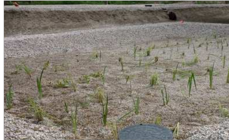
Fertiggestellte Pflanzenkläranlage für 30 Einwohnergleichwerte
