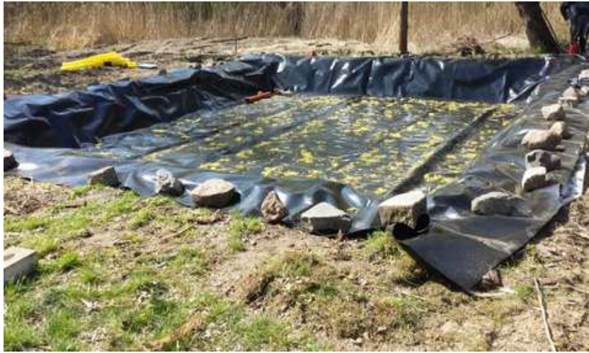
Horizontalfilter während der Bauphase
